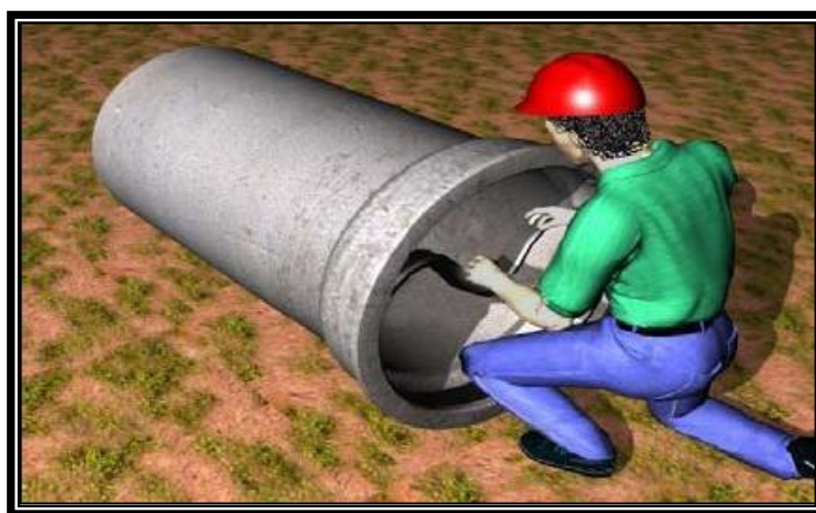
Figura 15 - Colocação do anel de borracha
